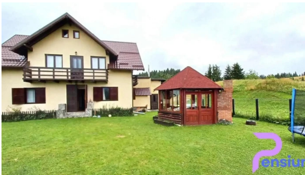
Casa in varf fundata
